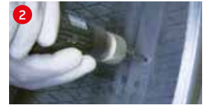
Schadenskanal bearbeiten (zweimal von innen und außen)
