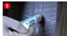
Stichkanal mit CEMENT SC-FD gummiern / MINICOMBI einstecken und einziehen
