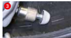
Reparaturstelle gleichmäßig rauhen
