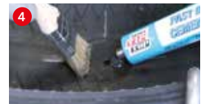
Reparaturstelle mit CEMENT SC-FD einstreichen / Trockenzeit beachten
